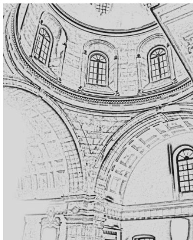
Fig. 3 - Interior da cúpula (vista trecho do tambor, triangulo esférico em rocha calcarea e capiteis em arenito).
