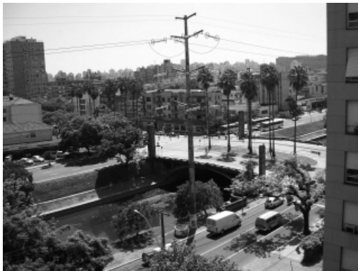
Arroio Dilúvio - Porto Alegre. Imagem tomada a partir do Hospital Ernesto Dorneles em março de 2006.
