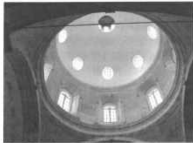
Foto 7: Interior da cúpula Fonte: Arquivo MSB
