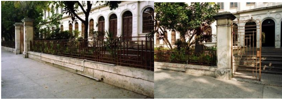
Instalação com conduítes eletrificados, na frente das Oficinas Oswald de Andrade, no bairro do Bom Retiro, em São Paulo, 1999
