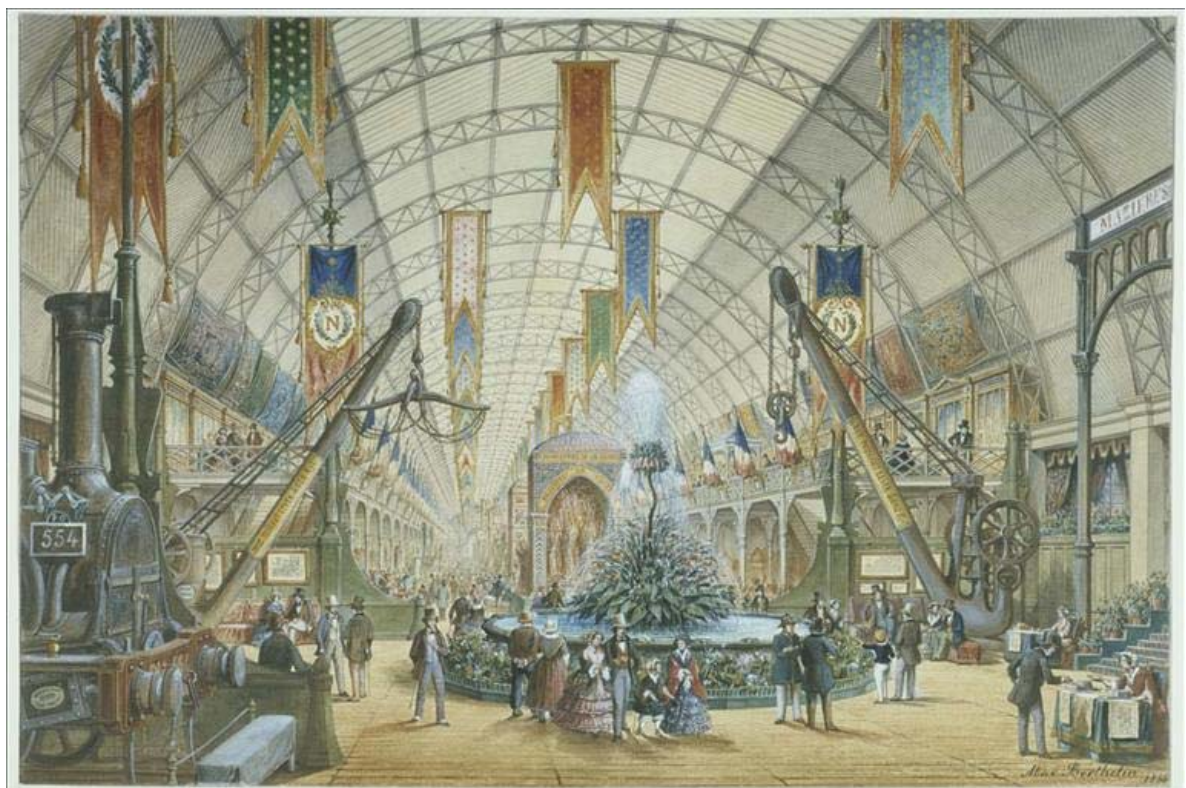
Fig. 5. Vista interior da galeria das máquinas, Exposition Universelle de 1855. Max Berthelin (1811-1877). Bico de pena e guache, 1855.
