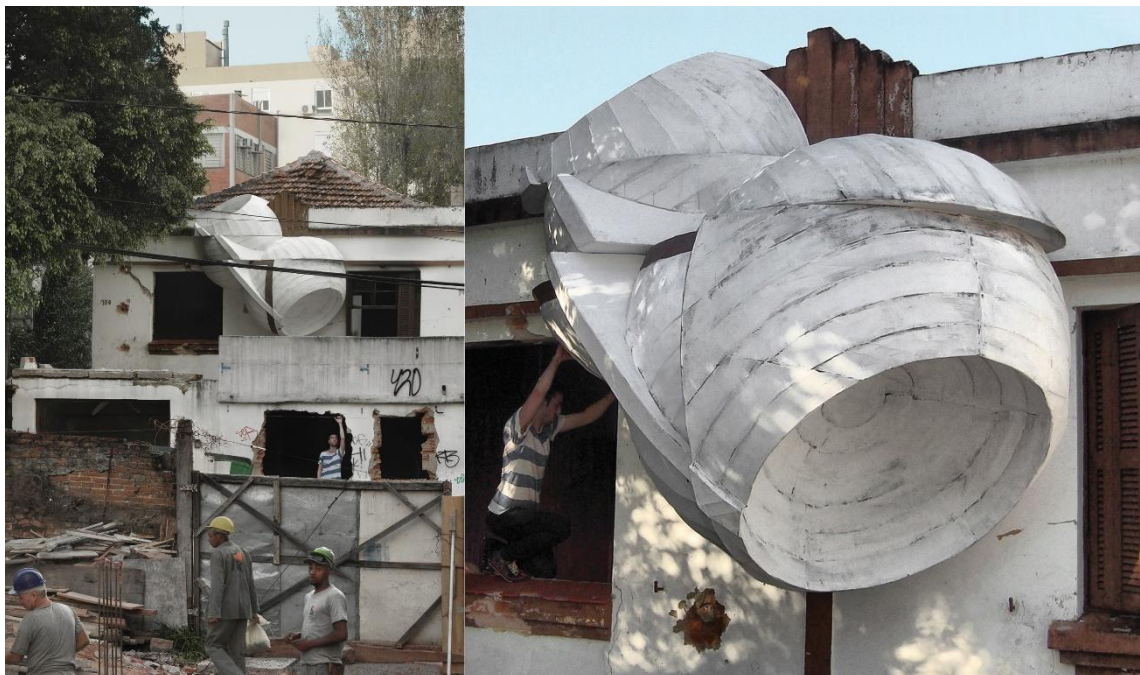
Figura 1 – Intervenção #4 - objeto de papelão sobre residência em demolição. Rua Duque de Caxias, Santa Maria/RS. Ano de 2013.
