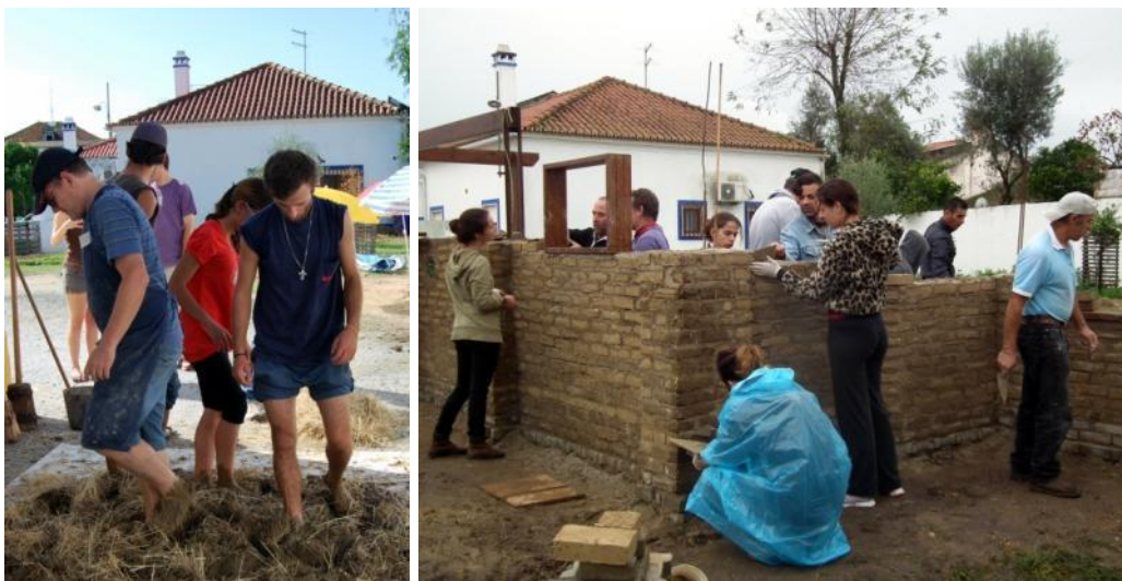
Desenvolvimento da ação participativa Entremuros , elaboração dos tijolos e construção da instalação de adobe Fotografias: Centro Juvenil
