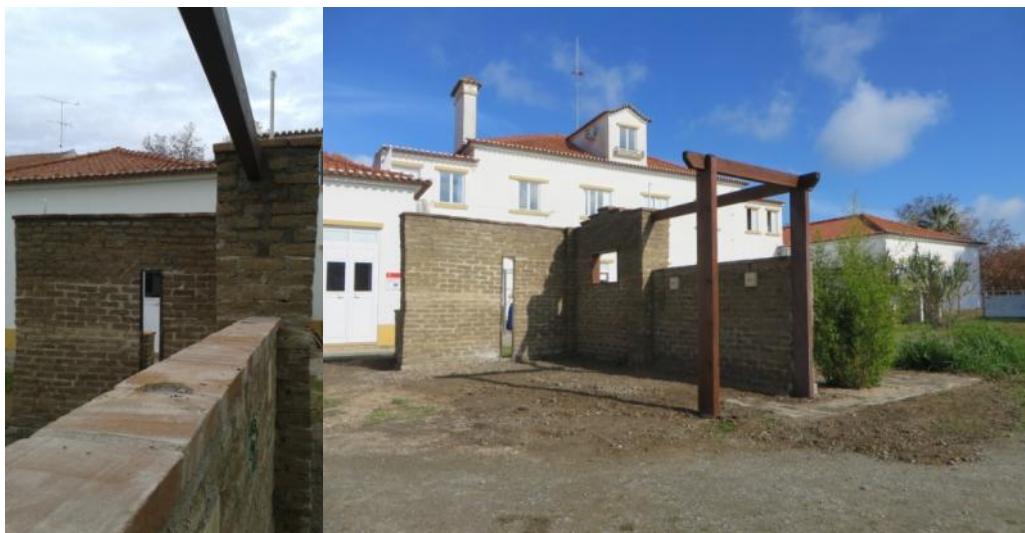
Entremuros presente na área externa do Centro Juvenil da Cidade de Montemor-o-Novo, aproximadamente 2,70 x 10,0 x 3,20 metros Fotografias do autor
