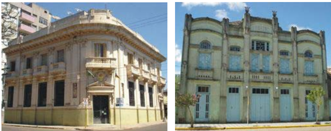
Figura 4: Os prédios com função comercial ou cultural. Na imagem à esquerda, 1: A antiga sede do Banco Pelotense , Santana do Livramento. Na imagem à direita, 2: A fachada do Teatro Independência , Santa Vitória do Palmar. Fonte: Fotos do autor, 2006.
